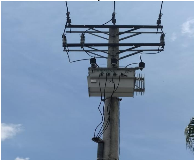
Transformador rayos x
