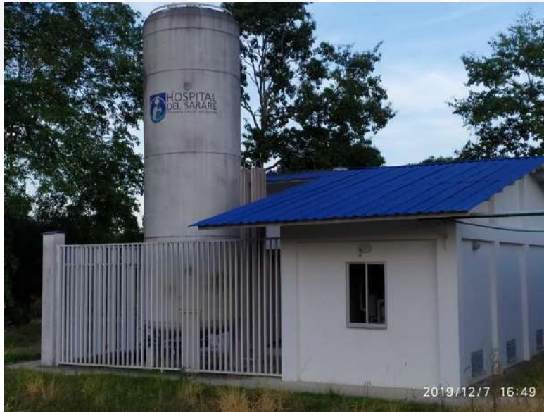
Imagen 1. Central de Gases medicinales de la E.S.E Hospital del Sarare.
