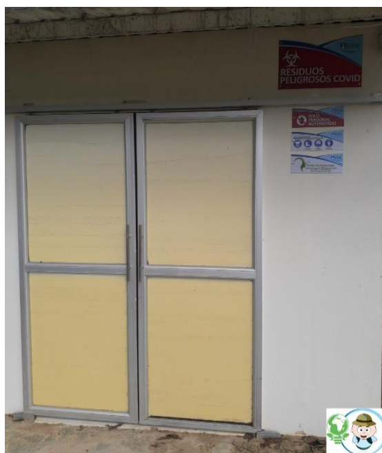
Fotografía 14 Sitio de Almacenamiento central de Residuos Covid-19 Sede Principal
