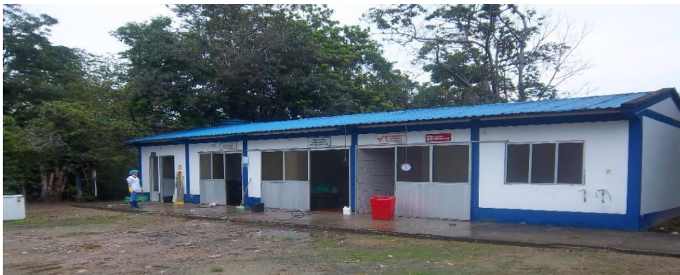
Fotografía 13 Sitio de Almacenamiento central de Residuos Sede Principal
