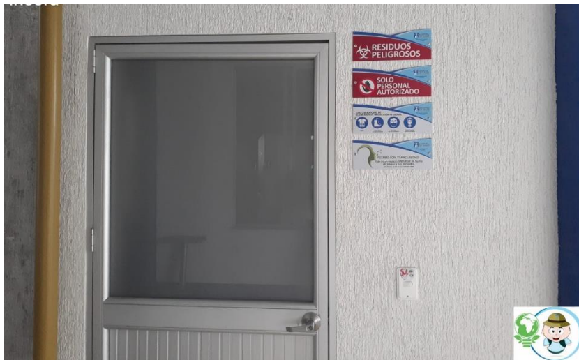
Fotografía 8 Sitio de Almacenamiento temporal de Residuos Sede Principal – Ginecobstetricia
