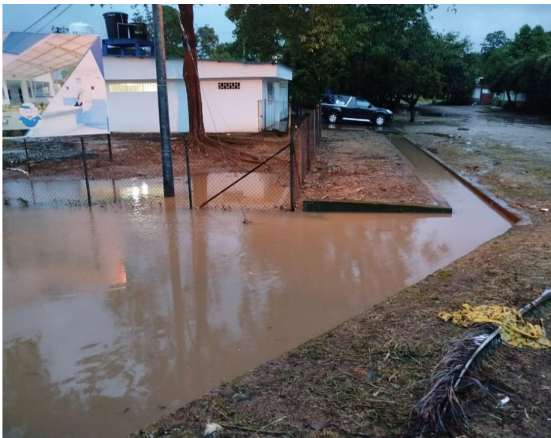
Imagen 1. CANAL EXISTENTE DEFICIENTE
