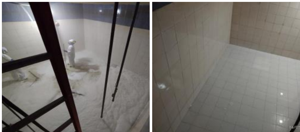
Fotografía. 1 Lavado de tanque subterráneo el 05/03/2025
