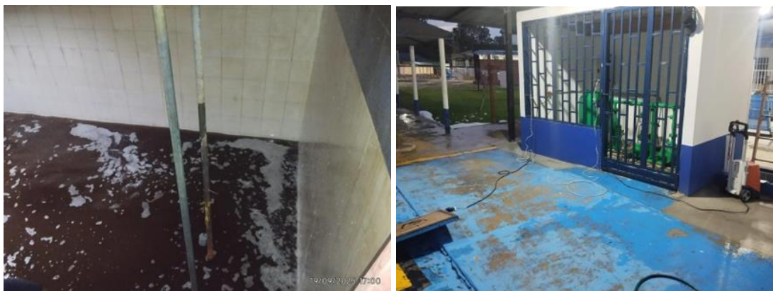
Fotografía. 2 Lavado de tanque subterráneo el 19/09/2025
