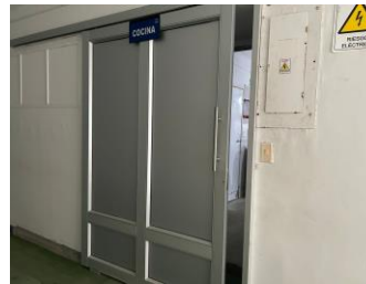
Puerta nueva acceso a la cocina
