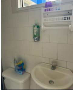
Se encuentra 1 solo lavamanos y esta ubicado en el baño
