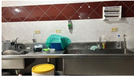
Zona de lavado
