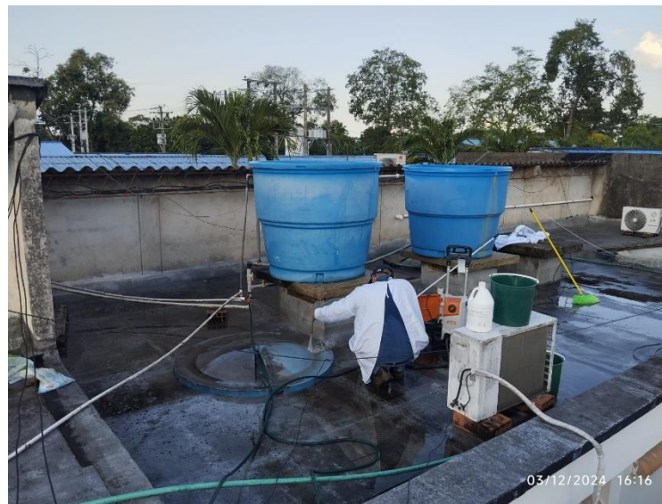
Ilustración 35 Lavado del Tanque
