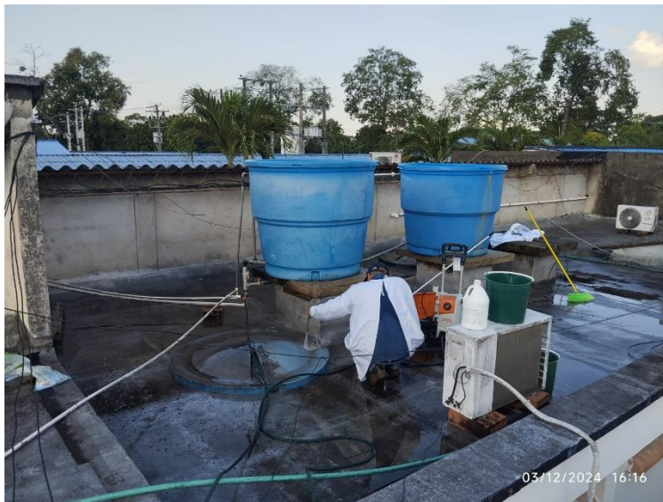
Ilustración 35 Lavado del Tanque .... 32
