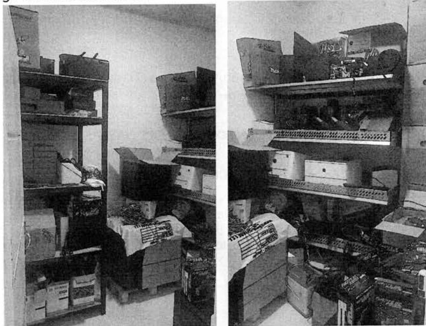
Ilustración 16 Bodega de sistemas
