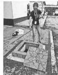
Después del Lavado del Tanque Subterráneo
