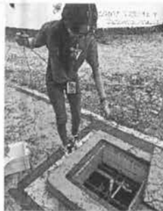
Antes del Lavado del Tanque Subterráneo
